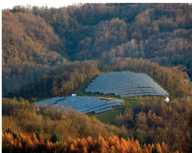
Največja sončna elektrarna v občini.
