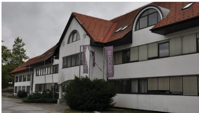
Alposova poslovna stavba v Šentjurju.
